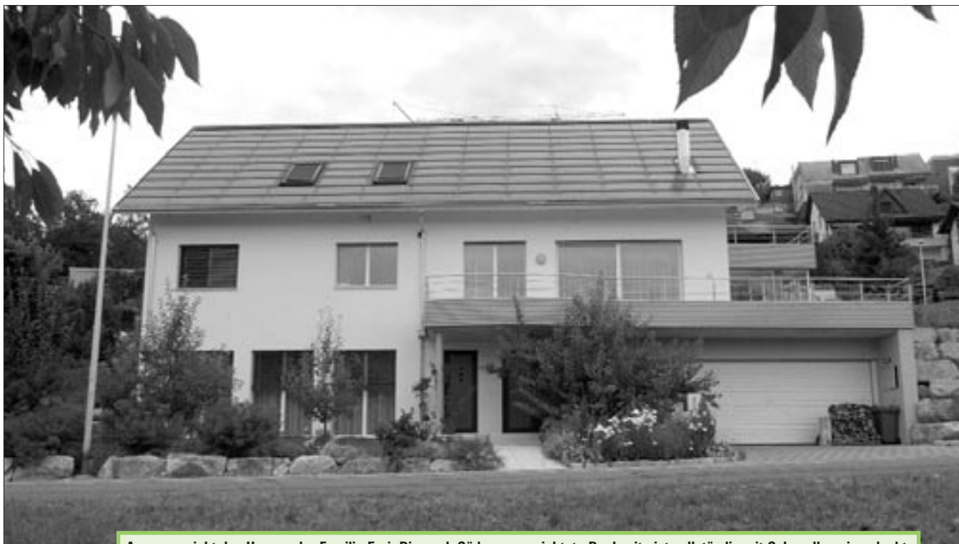
Aussenansicht des Hauses der Familie Erni. Die nach Süden ausgerichtete Dachseite ist vollständig mit Solarzellen eingedeckt.
