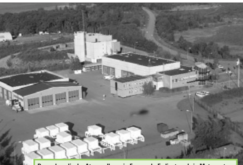
Das schwedische Atomendlager in Forsmark: Es liegt sechzig Meter unter dem Ostseeboden, gilt als unsicher und war von Anfang an undicht.
