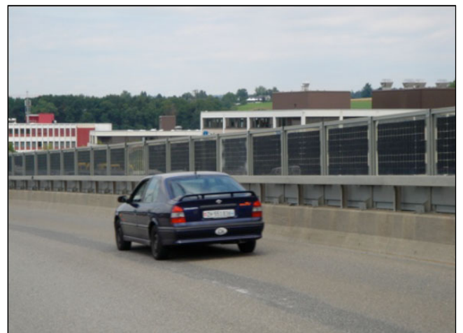
Abbildung 43 Bi-faziale Solarzellen, vertikal aufgeständert (Bild: Photon)
