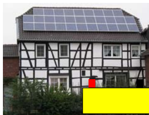
Eigenverbrauch in PV-Anlagen
