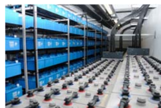
Unterbrechungsfreie Stromversorgung (USV)
