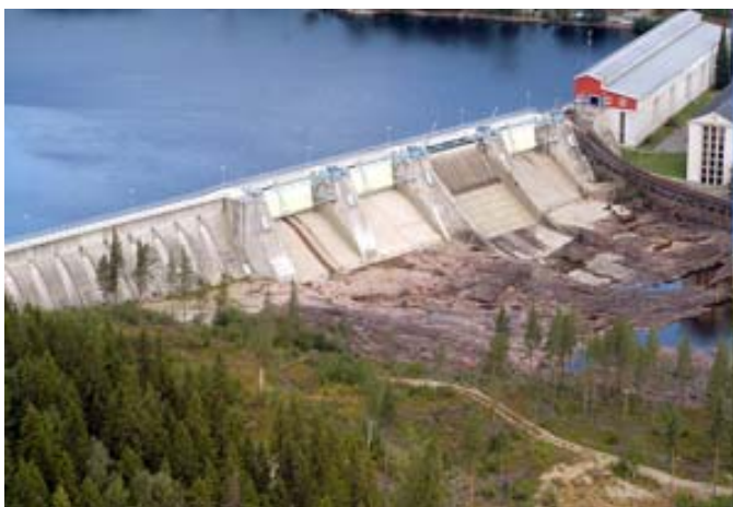
Wasserkraftanlage Harspranget / Schweden 939 MW, 2 TWh/Jahr
