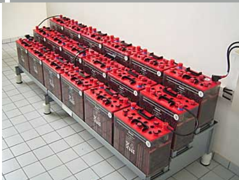
Quelle: www.kausch.de E.ON Thüringer Energie AG; Spichra bei Eisenach
